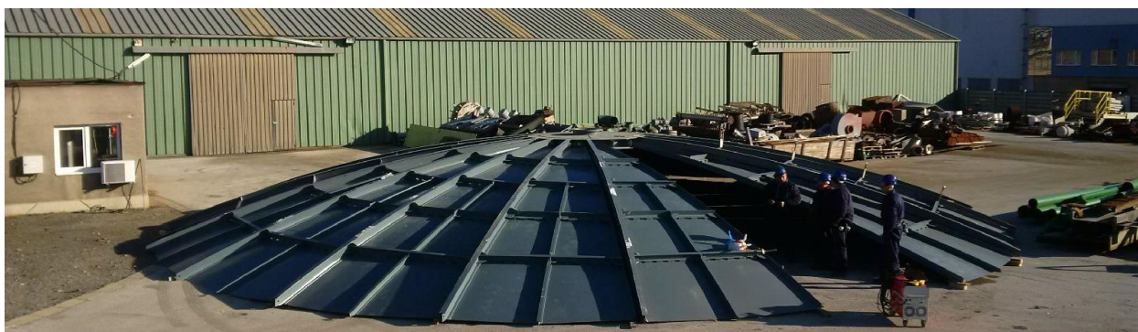
Фиг. 9. Изработване и сглобяване на покрива.
